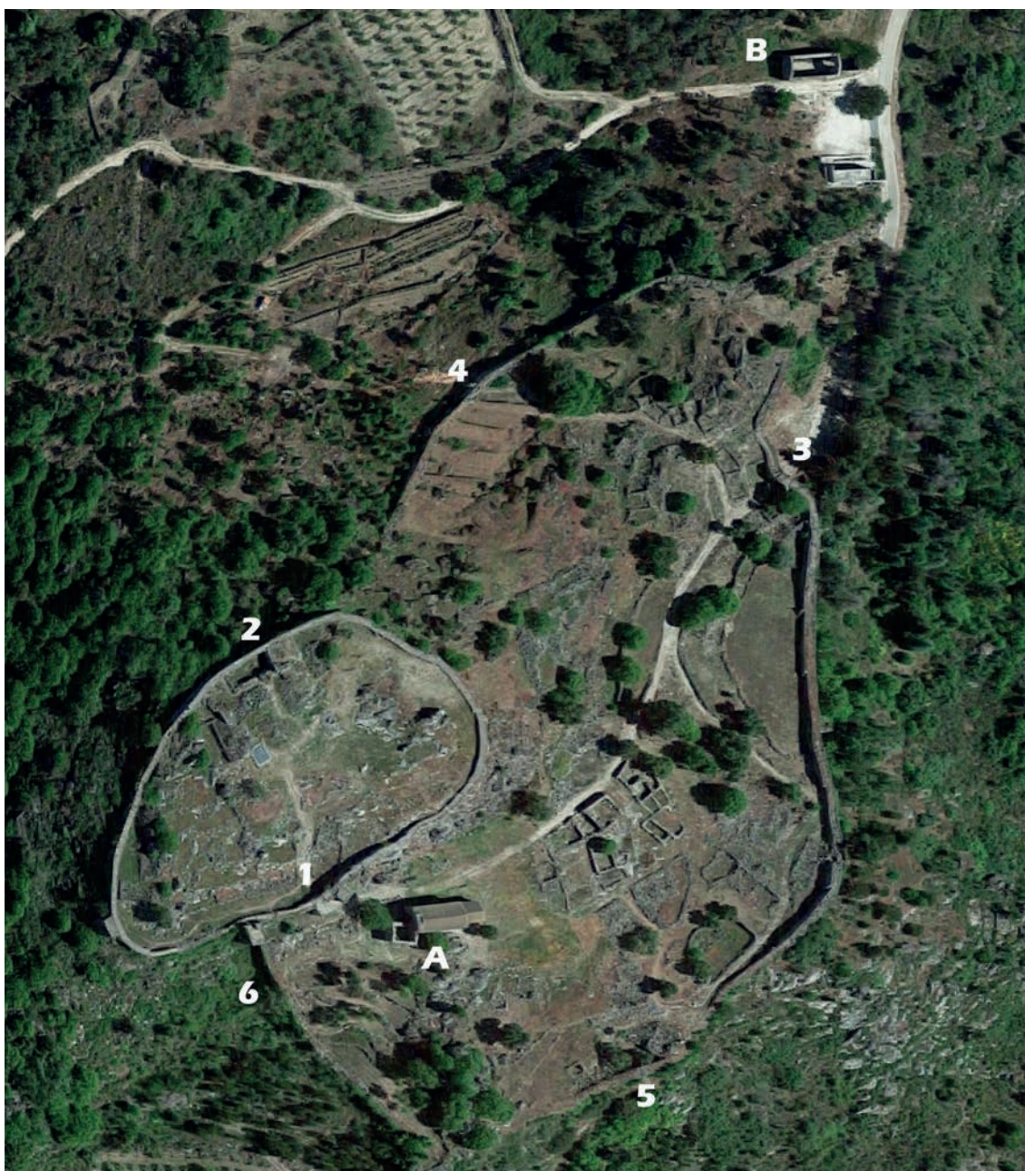
Vista aérea do Castelo de Ansiães: 1- Porta do Salvador. 2- Porta da Traição. 3- Porta de São Francisco. 4- Porta de São João Baptista. 5- Porta da Vila. 6- Porta da Fonte Vedra. A- Igreja de São Salvador. B- Igreja de São João Baptista de Extramuros (Fotografia ©2022 Google, Imagens ©2022 CNES / Airbus, IGP/DGRF, Maxar Technologies, Dados do mapa ©2022).
