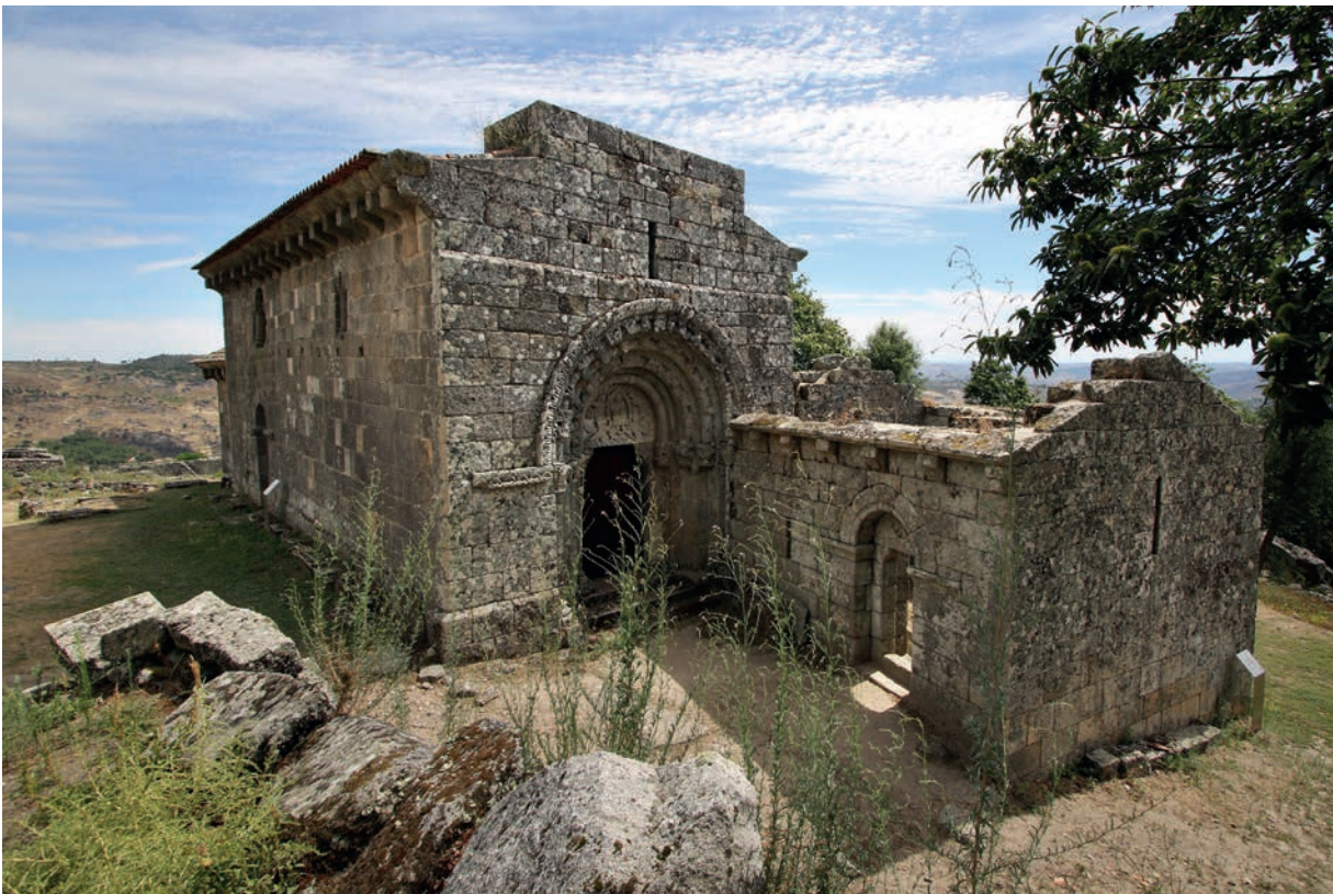
Vista geral a partir de oeste
