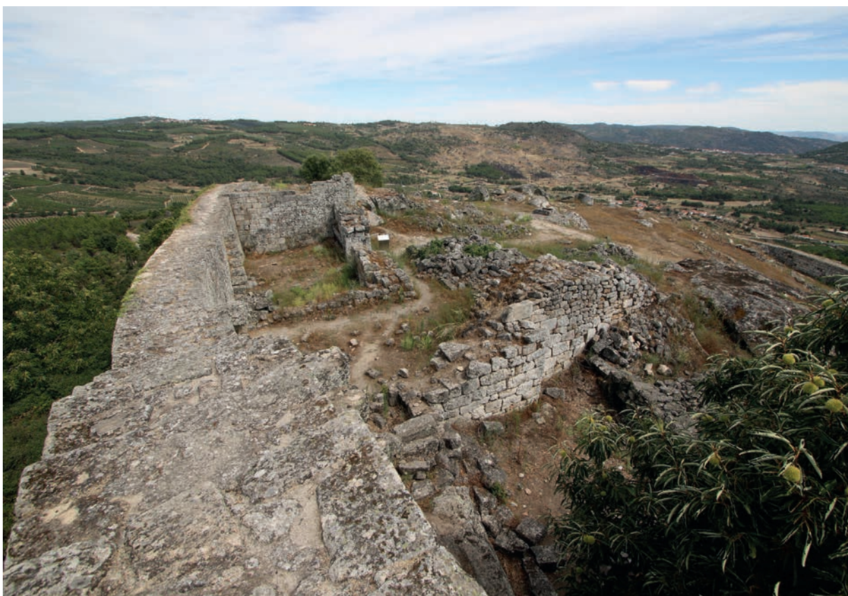
Estruturas do recinto superior junto à muralha noroeste. Ao fundo, a Torre de Menagem
