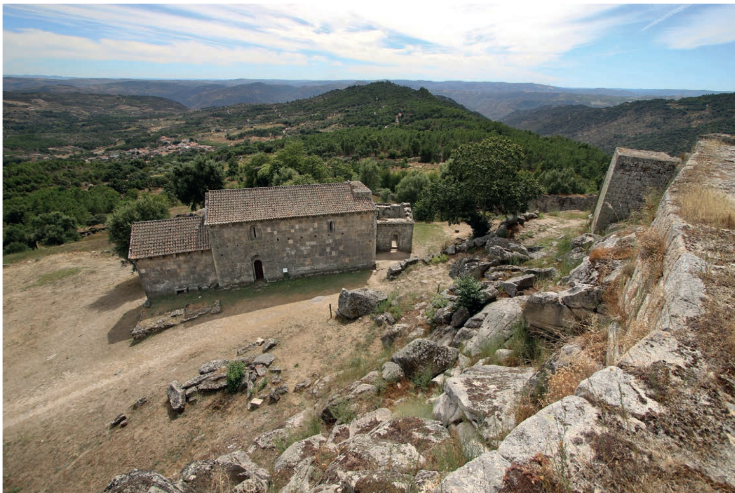
Vista da igreja de São Salvador de Ansiães a partir do recinto amuralhado superior
