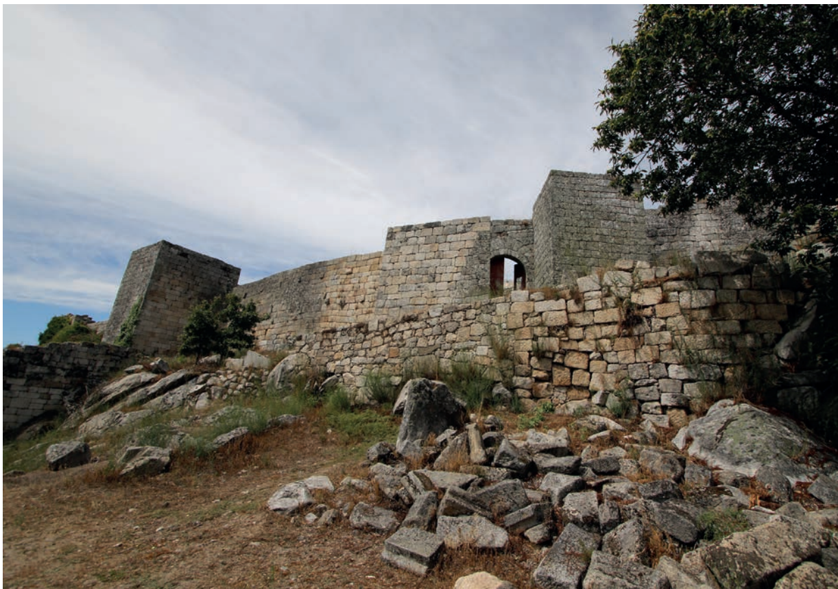
Acesso ao recinto superior: Porta do Salvador
